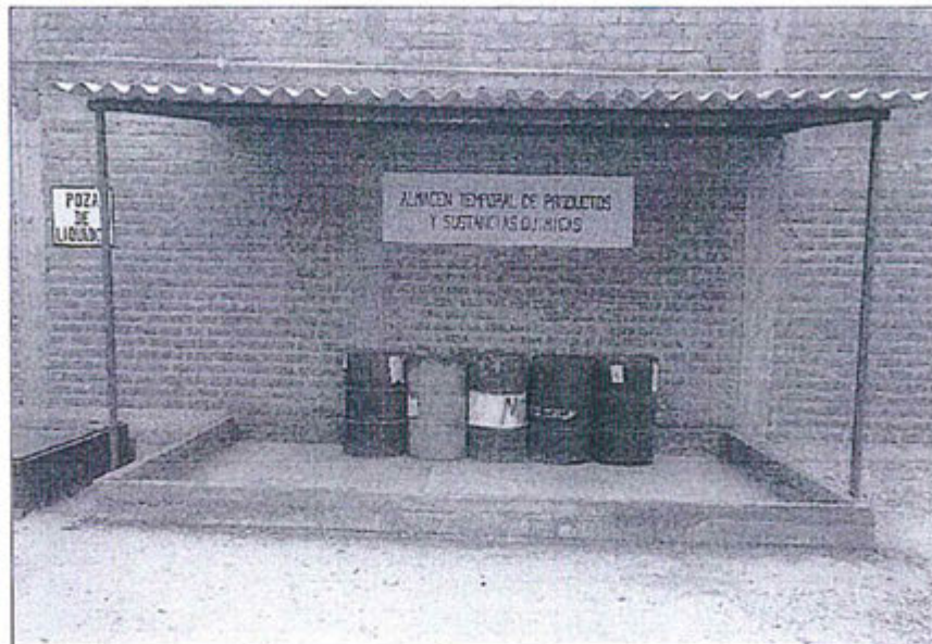
Figura N° 13: Actualmente se está usando el área para almacenar cilindros con combustibles.
