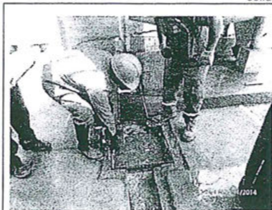
Fotografía N° 7 del Informe de verificación de medida correctiva: Trampa de grasa y filtro de sólidos 2
