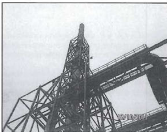
Fotografía N° 92: Punto de monitoreo de chimenea de la planta de ánodos.
