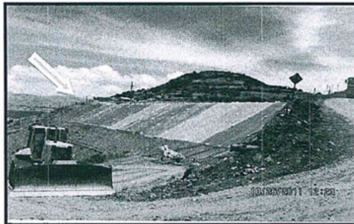
Fotografía N° 48 del Informe de Supervisión: "Levantamiento de la Observación N° 14 (Incumplimiento de Recomendación N° 14): Colocación de la manta plástica en el talud del depósito de relaves "Amanda I"."
