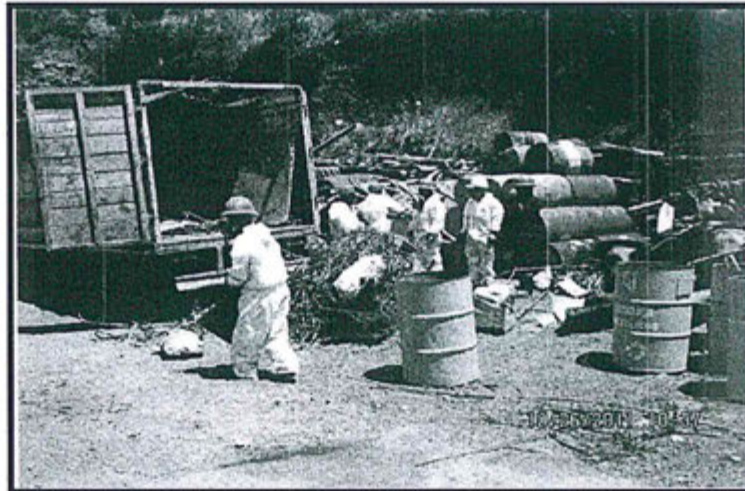
Fotografía N° 11 del Informe de Supervisión: "OBSERVACIÓN N° 09: Área de almacenamiento temporal de aceites usados y residuos industriales, ubicado entre las coordenadas UTM WGS-84: Norte 8443759, Este 615587 y cota 3370, cuenta con un sector sin loza de concreto ni canales de colección de derrames."
