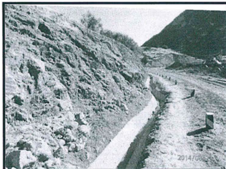
Fotografía N° 1: cunetas de los accesos hacia la el depósito de relaves Amanda
