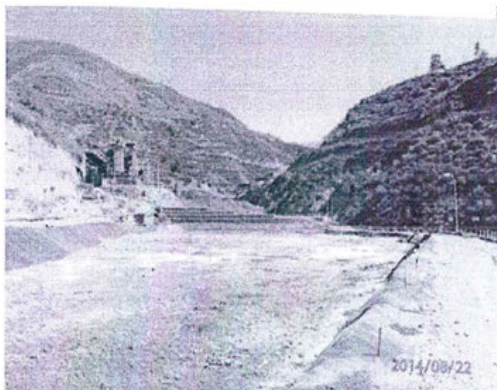
Fotografía N° 5. Depósito de relaves N° 6 con geomembrana en los bordes de dicho depósito
