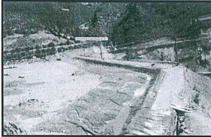
"Fotografía N° 4: Depósito de Relaves Amanda – Plataforma."
