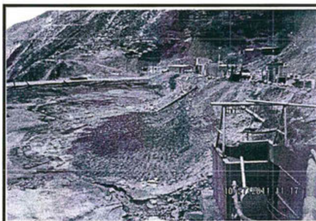
Fotografía N° 46 del Informe de Supervisión: "Levantamiento de la Observación N° 13 (Incumplimiento de Recomendación N° 13): El titular minero
