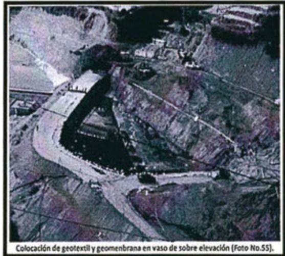
Colocación de geotextil y geomembrana en vaso de sobre elevación (Foto No.55).
