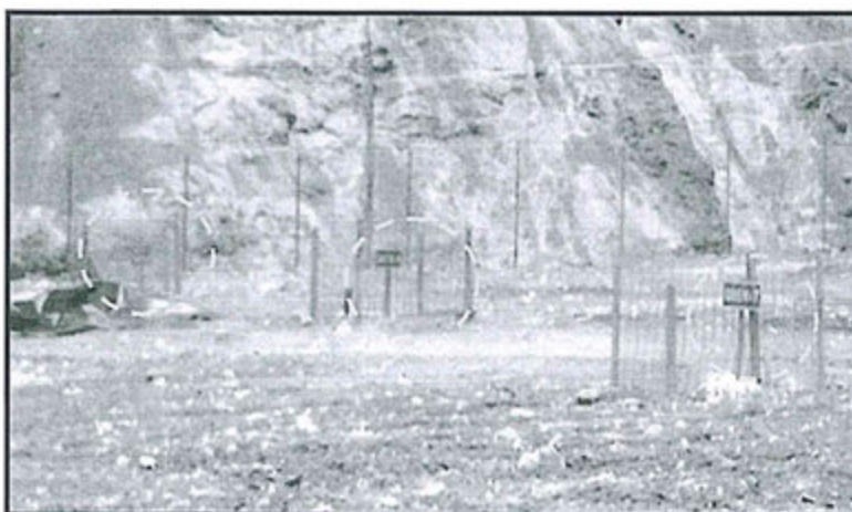
Fotografía N° 33.- Recomendación N° 17: Chimeneas de evacuación de gases con identificación respectiva.
