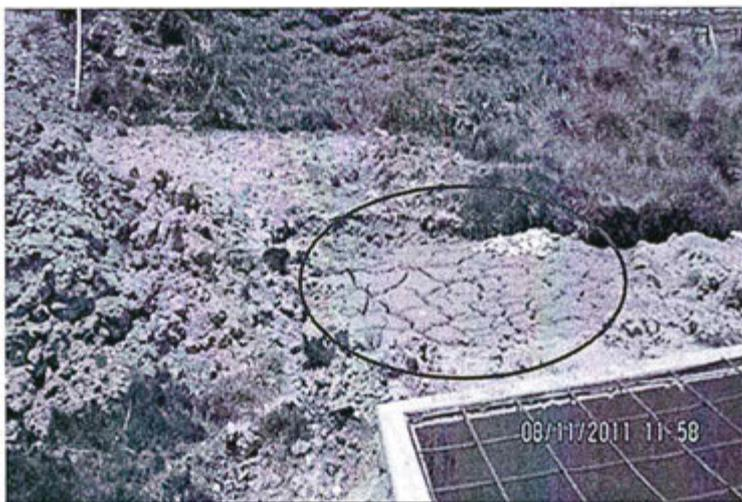
Foto 07: Poza de sedimentación del taller de mantenimiento sin poza de secado de lodos, obsérvese la acumulación de lodos al costado de la poza de sedimentación, sobre un área con vegetación natural.
