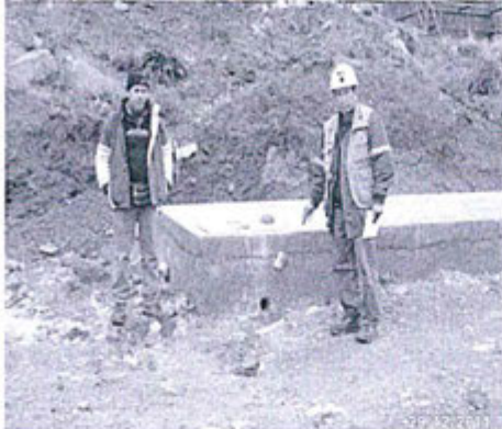
Fotografía N° 12: Frente a la Planta de Beneficio Ana María se observó un efluente doméstico proveniente de un pozo séptico.
