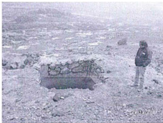
Fotografía N° 1: En la plataforma y taladro DH-02 se observó pozas de lodos donde falta concluir el cierre de acuerdo a instrumento de gestión ambiental.
