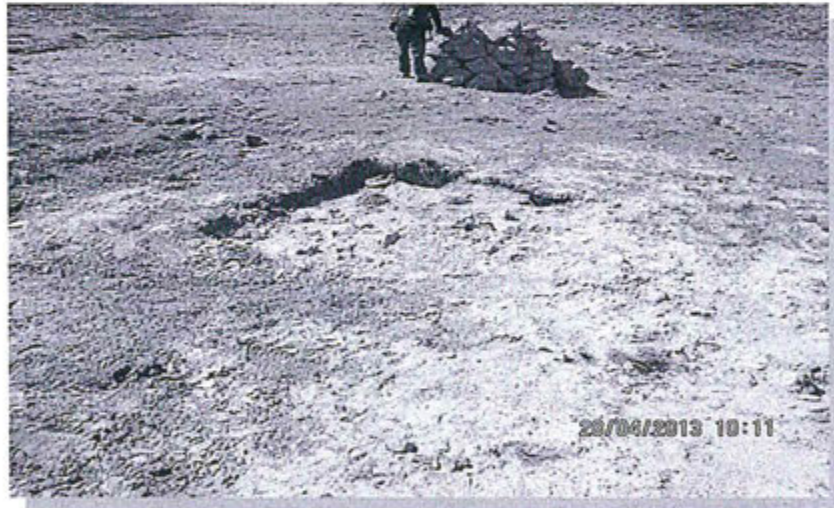
Foto 01: Hallazgo N° 1: En la poza de sedimentación de la plataforma NIL12-01, con coordenadas UTM: 8 388 923N y 403 686E, se observa la falta de nivelación y revegetación.
