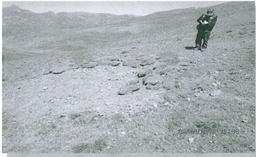
Foto 02: Hallazgo N° 1: En la poza de sedimentación de la plataforma MAR 12-02, con coordenadas UTM: 8 386 769N y 404 286E, se observa la falta de nivelación y revegetación.
