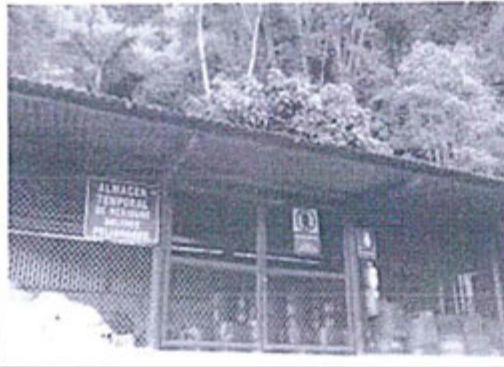
Almacen temporal de residuos Peligrosos
