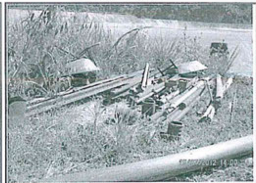
FOTOGRAFIA N° 31.- Observación N° 11: En el área contigua de la estación de bombas del depósito de relaves, coordenadas UTM WGS 84: 8 762 169 N, 463 947 E y 980 msnm., se observó restos de tuberías de HDPE, tuberías de fierro, madera.
