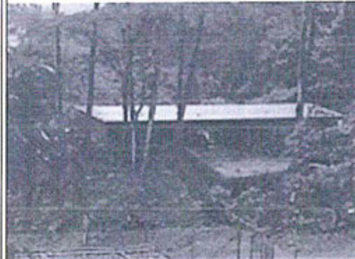
Almacen Temporal de Residuos Sólidos
