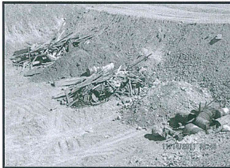
Fotografía N° 5.- (Obs. N° 3): Depósito improvisado de chatarra y otros materiales como madera y fierros
