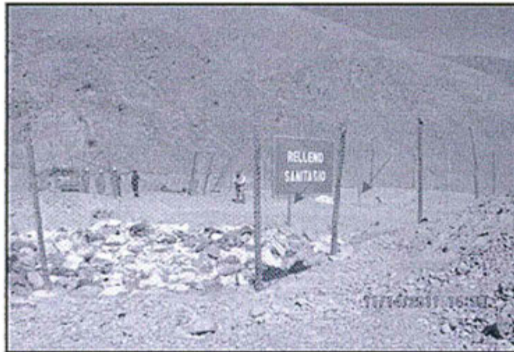
Fotografía N° 27.- (Proyecto PAMA N° 5): Se han instalado dos chimeneas de ventilación para el relleno sanitario.
