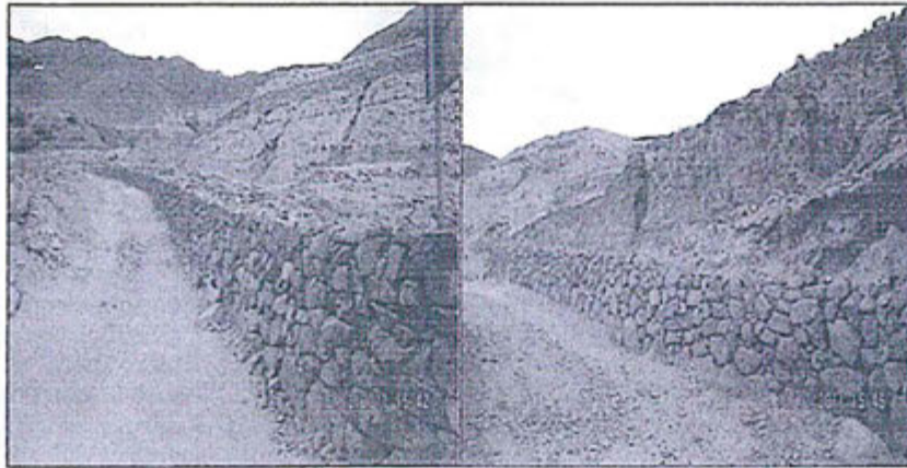
Foto N° 14: Construcción de muro de piedras en el pie de talud de presa de relaves para la protección en caso de fuertes avenidas.
