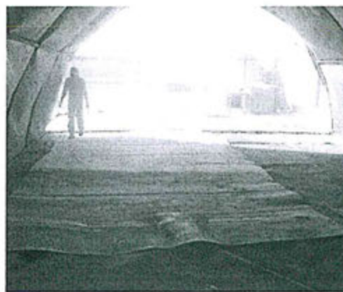
Fotografías N° 01 y 02 (04/05/2012): Izquierda : Proceso de Limpieza de la zona, Derecha : Reemplazo de geomembrana deteriorada
