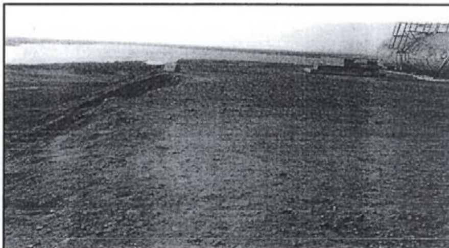
Observación N° 3.- Acción correctiva: se retiró del lugar todo material orgánico que se encontraba desordenado, así como también, chatarra, entre otros; en su lugar se está construyendo una pequeña zona de almacenamiento temporal de residuos, con su respectiva señalización.
