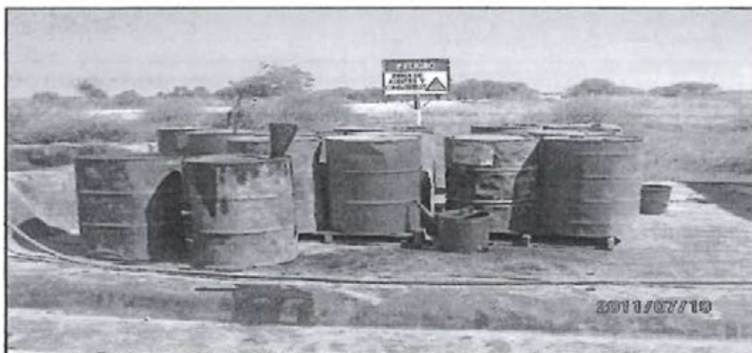
Fotografía N° 8.- Vista del área de almacenamiento de aceites y combustibles, durante la perforación del pozo PN 146 del Lote XIII-A, véase que el área de contención carece de un muro en la parte posterior (cerca al sembrío).
