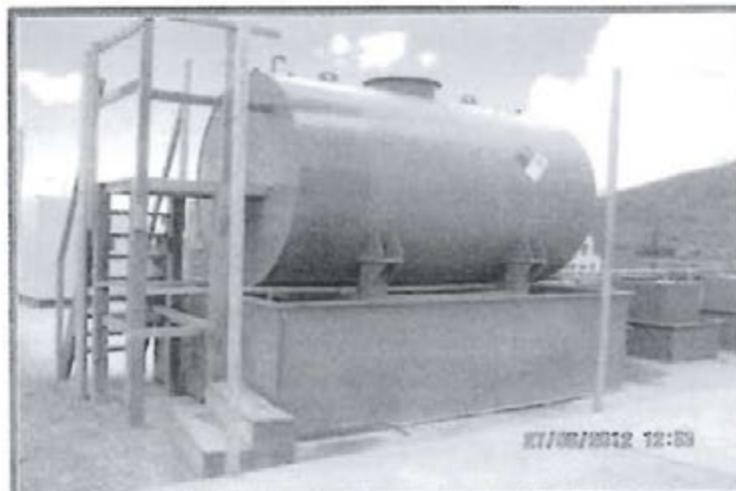
FOTOGRAFIA N° 22.- Observación N° 5: En el campamento Charcacocha, se observó que el área donde se dispone el tanque de combustible (en proceso de construcción), aún no cuenta con la identificación respectiva, asimismo falta implementar los sistemas de respuesta ante una posible contingencia.
