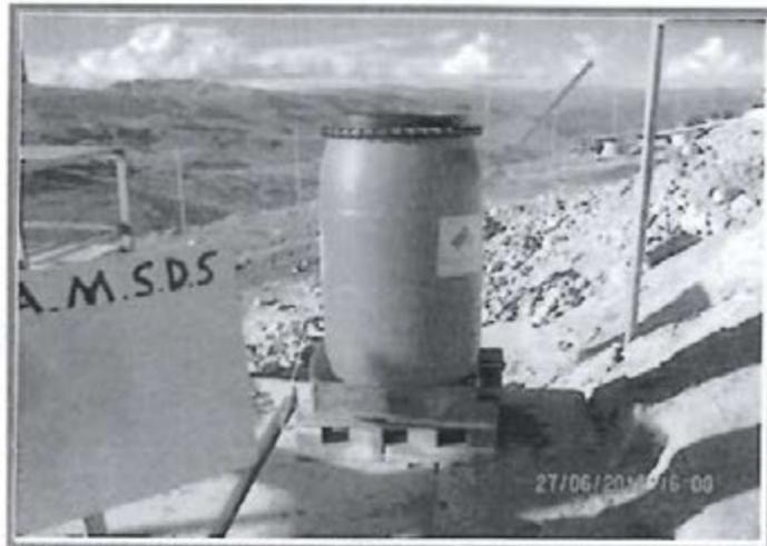
**FOTOGRAFIA N° 28.- Observación N° 07:** Se verificó la existencia y operatividad de un pozo séptico en la zona del campamento Pumamarca, en el cual, el reactivo empleado (hipoclorito de calcio en solución) no se encuentra debidamente asegurado y no cuentan con el kit de emergencia ante un posible derrame del contenedor del hipoclorito de calcio en solución.
