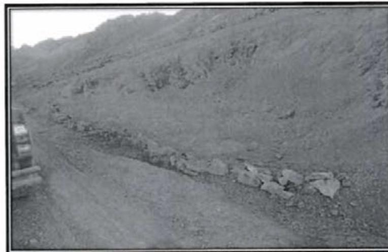
Fotografía N° 3 del Informe de Supervisión: En el proyecto de exploración "Santa Este", las plataformas de perforación de sondajes y sus accesos, se encuentran con cierre incompleto del área y no se visualizan los sondajes correspondientes cerrados.
