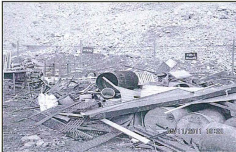
**Fotografía N° 52:** En el área de transferencia de residuos industriales de Scrap se encontró materiales plásticos, estructuras metálicas, cilindros entre otros, sin su clasificación, identificación y falta de orden.
