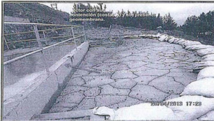
Fotografía N° 20: Recomendación N° 1; Vista fotográfica del sector junto a la poza no se encuentra impermeabilizado y presentando en algunos sectores ausencia del muro de contención. Así mismo se observa evidencia que los lodos ya han rebalsado el muro de cemento.
