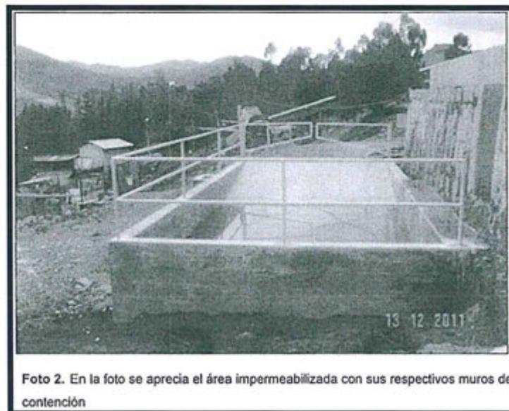
Foto 2. En la foto se aprecia el área impermeabilizada con sus respectivos muros de contención
