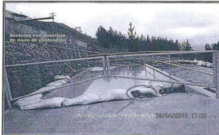
Fotografía N° 19: Recomendación N° 1 Vista fotográfica del sector junto a la poza no se encuentra impermeabilizado y presentando en algunos sectores ausencia del muro de contención. Así mismo se observa el muro de contención de la poza deteriorado.
