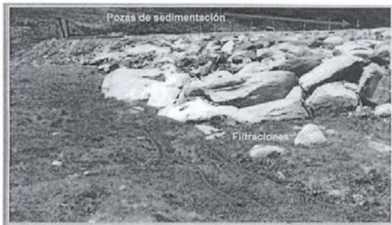
Fotografía N° 12 del Informe de Supervisión: Se constató que detrás de las pozas de sedimentación N° 1 y 2 de bocaminas Nazca-Paracas y a una distancia aproximada de 3 m. del punto de control E-04, existen filtraciones sobre suelo natural.
