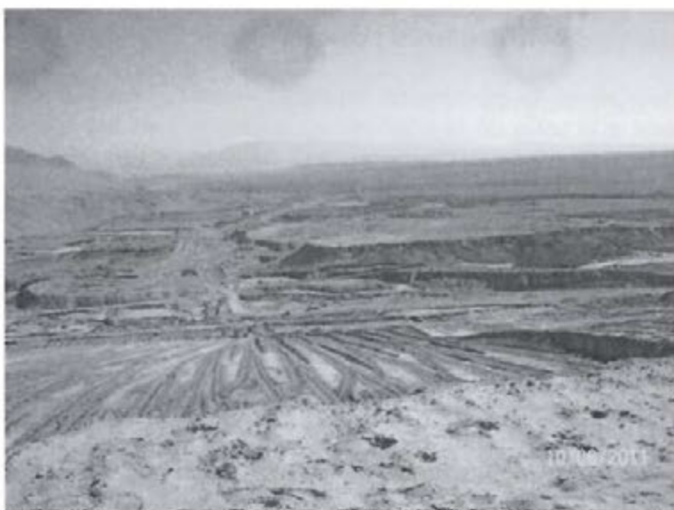
Fotografía N° 18: La empresa tiene acumulados los relaves fuera de las pozas de sedimentación, en un depósito provisional que indican, serán usados en el dique de contención de relaves 65
