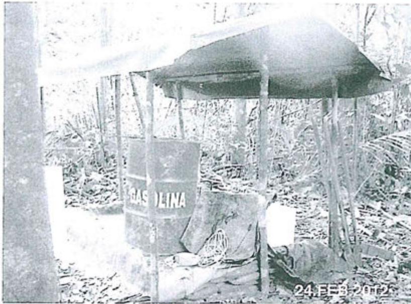
Fotografía N° 8: La poza de contención de combustibles del campamento volante 1-2, tiene capacidad de contención insuficiente ante un derrame de combustible.
