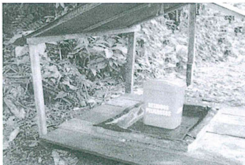
Tacho de residuos peligrosos, etiquetado y con bases de geomembrana.
