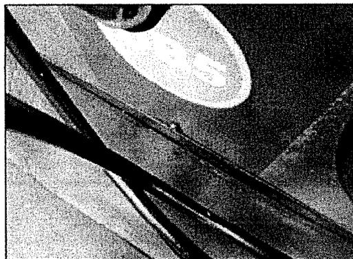
Fotografía N° 10: Isla N° 2 se observa base de dispensador con presencia de hidrocarburo ocasionado por posible fuga y derrame
