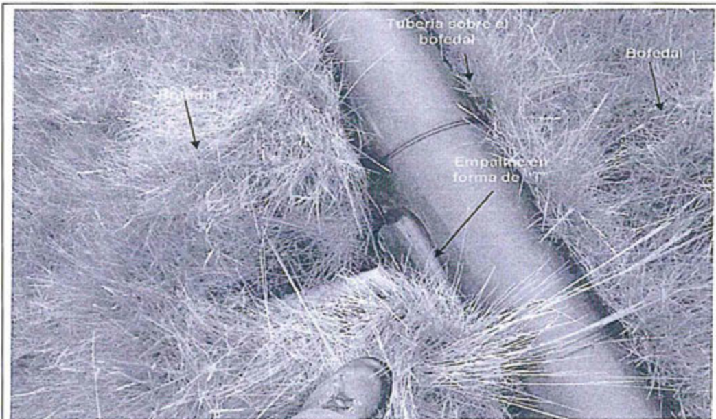
Fotografía N° 24.- Observación N° 2 - 2013: Empalme en forma de "T" de la tubería que recorre el bofedal con el punto de salida hacia el bofedal
