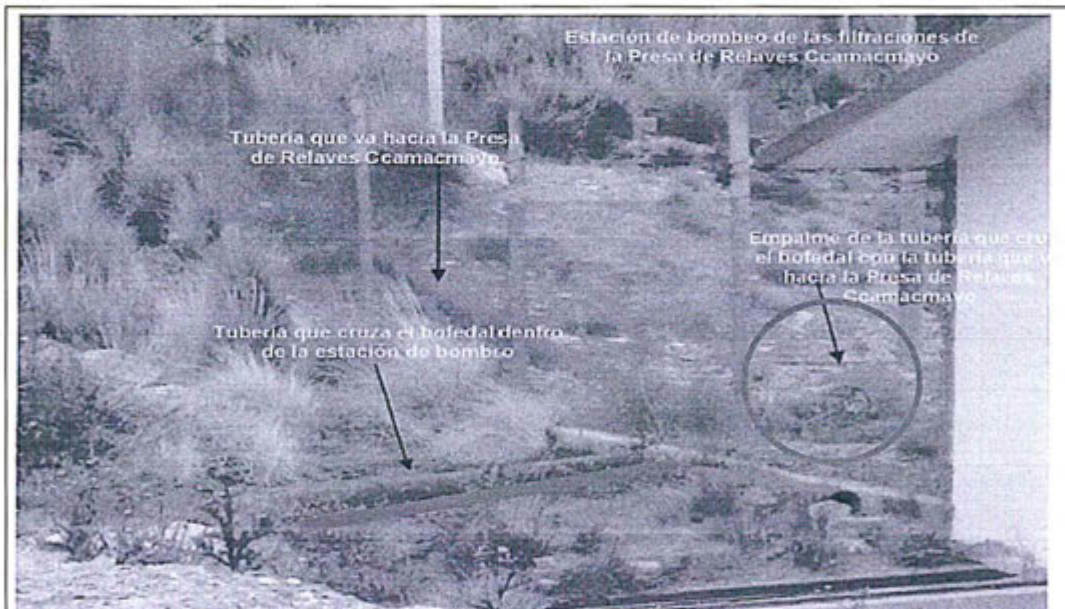
Fotografía N° 23.- Empalme de la tubería que cruza el bofedal con tubería que va hacia la Presa de Relaves Ccamacmayo.
