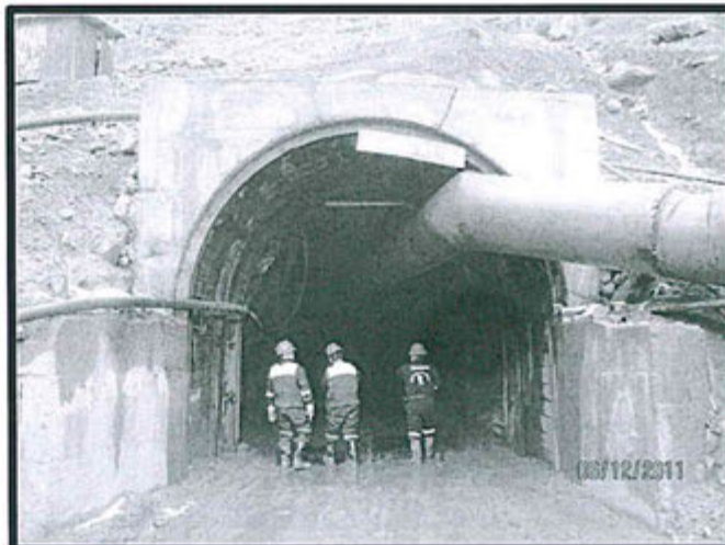
FOTO N° 24: Levantamiento de la observación N°1-2010 (Supervisión Especial): Bocamina del nivel 890 (nivel 4890), que constituye la rampa de pendiente negativa (12%), por el cual se extraen los desmontes, no presenta drenaje de agua de mina.
