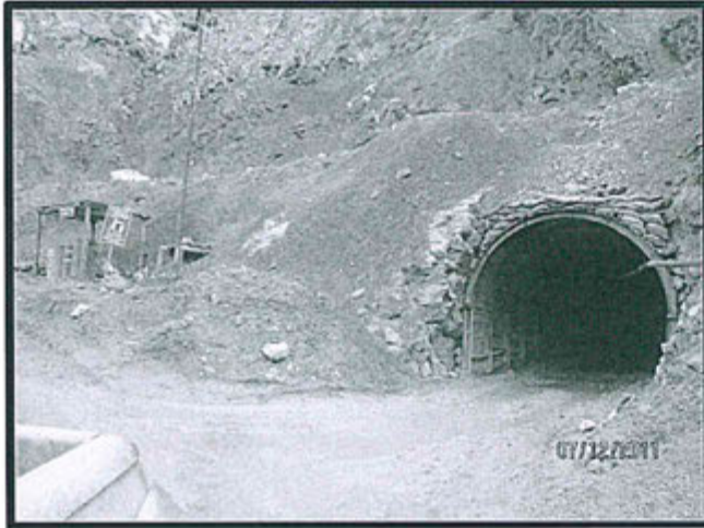
FOTO N° 21: Levantamiento de la observación N°1-2010 (Supervisión Especial): Después Bocamina del nivel 4980, en rehabilitación para tener acceso a labores en interior mina, no presenta drenaje de agua de mina.
