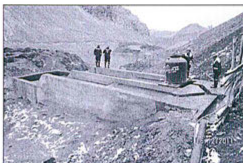
FOTO N°6: Observación N°2-2011: Las aguas de la Bocamina del nivel 4940 que pasaron la primera poza de sedimentación ingresan a dos pozas de sedimentación construidas con material de concreto
