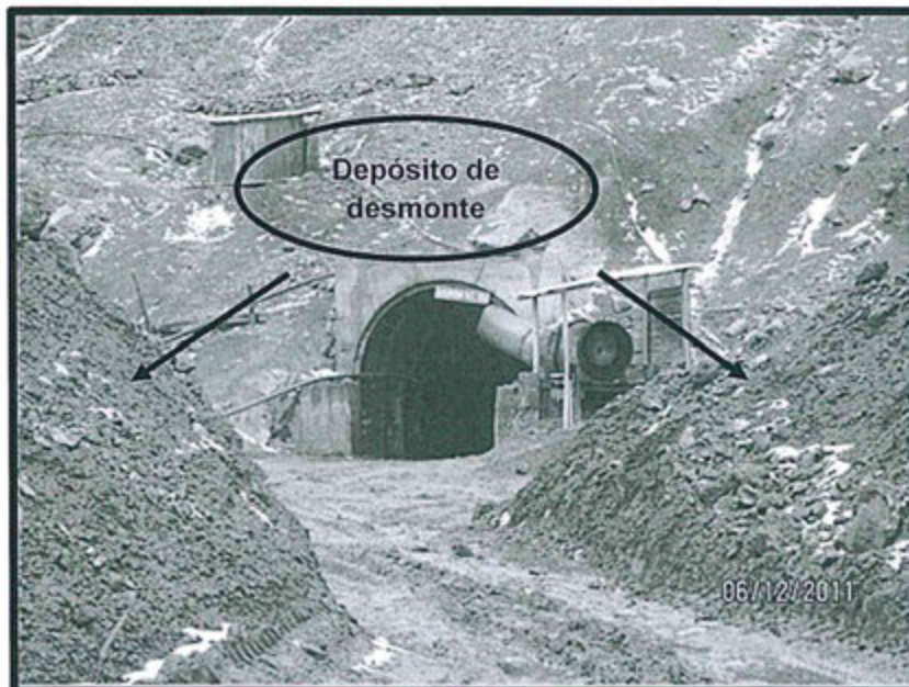
FOTO N° 23: La Bocamina del nivel 890 (nivel 4890), rodeada por el depósito de desmontes inactivo, no presenta drenaje de agua de mina.
