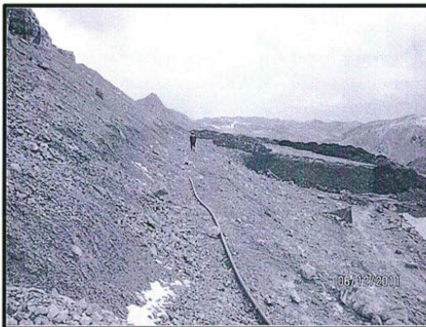
Foto N° 11: Observación N°4-2011: Vista del depósito de desmontes inactivo, ubicado en el talud de la quebrada que colinda con la Laguna Esperanza, sin canal de coronación.
