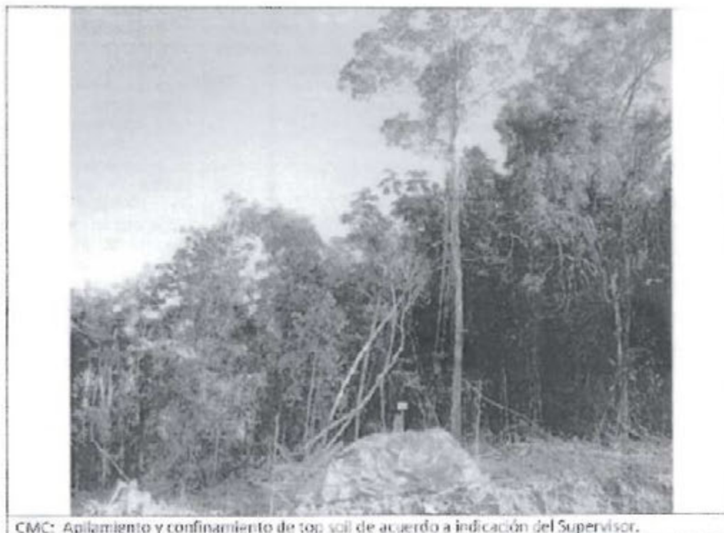
CMC: Apilamiento y confinamiento de top soil de acuerdo a indicación del Supervisor.
