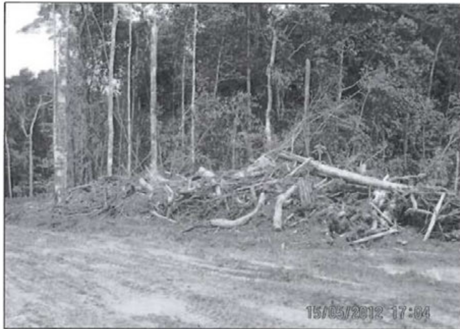
Fotografía N° 1: Vista del área de almacenamiento del Top soil (suelo orgánico), obsérvese que no cuenta con protección que pueda evitar la erosión por escorrentía.
