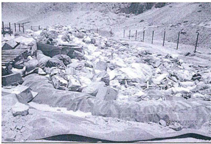
Foto 09: Observación 4, canales de coronación del relleno sanitario se encuentran sin mantenimiento, asimismo no cuentan con chimeneas, barrera sanitaria.
