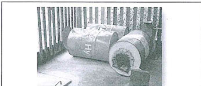
Vista Fotográfica N°5: Detalle del manejo de los residuos peligrosos ubicados en la C.H. Pichanaki, los barriles de aceites contienen residuos del mismo, sin embargo nótese que el piso no está impermeabilizado.
