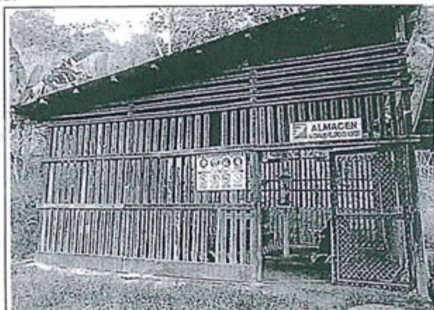
Fotografía 10: Fachada del Almacén de Materiales Peligrosos Aceites, con piso de concreto, estructura de madera debidamente ventilado, con columnas, techo y enmallado y protegido de las lluvias.
