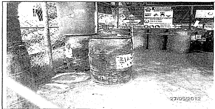
Fotografía N° 14: Vista del centro de almacenamiento de productos químicos y lubricantes en área inadecuadamente impermeabilizada. Obsérvese, que el área no tiene sistemas de doble contención (Coordenadas UTM - Sistema WGS 84: 0504725E, 9190223N).
