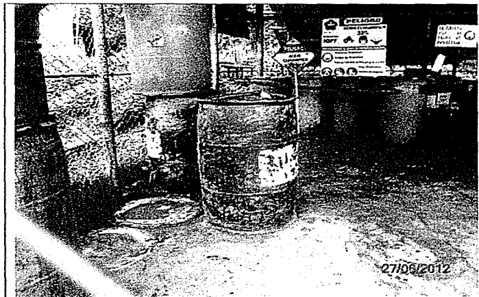
Fotografía N° 14: Vista del centro de almacenamiento de productos químicos y lubricantes en área inadecuadamente impermeabilizada. Obsérvese, que el área no tiene sistemas de doble contención (Coordenadas UTM - Sistema WGS 84: 0504725E, 9190223N).
