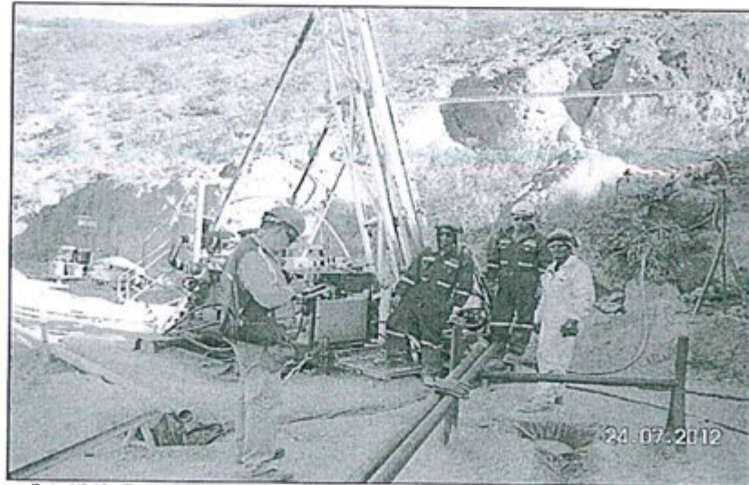
Foto N° 13.- Desarrollo del taladro PE-03 con la contrata GEO DRILL. La Supervisión lo ubicó en la zona 17L. E: 784712 / N: 9075224
