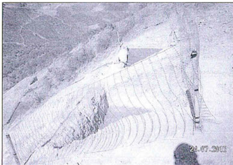
Foto N° 10.- Pozas de sedimentación del taladro de perforación PE-01. Construidas en las laderas del cerro a unos 25 metros aproximadamente del taladro desarrollado.
