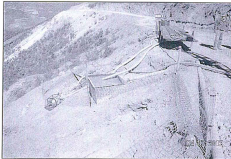
Foto N° 14.- Pequeña poza de sedimentación del taladro de perforación PE-03. Está construida con la finalidad de aprovechar las aguas clarificadas de los dos taladros anteriores. Se encuentra ubicado a unos 15 metros aproximadamente del taladro en desarrollo.
