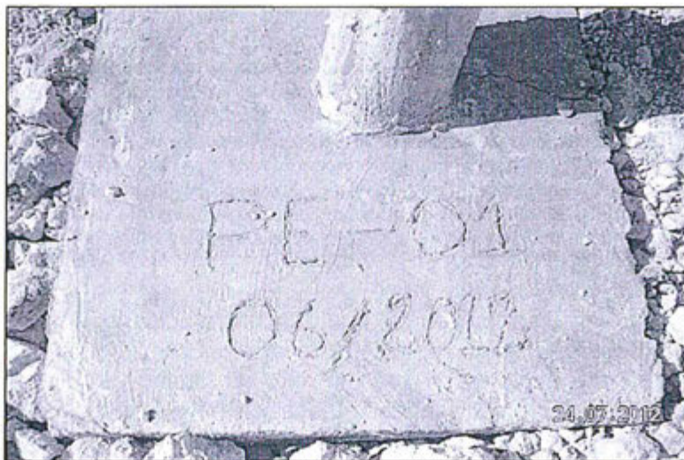
Foto N° 09.- Dado de concreto indicando la fecha de obturación y cierre del taladro PE-01. No indica coordenadas de ubicación y profundidad. La Supervisión lo ubicó en la zona 17L al E: 784687 / N: 9074688
