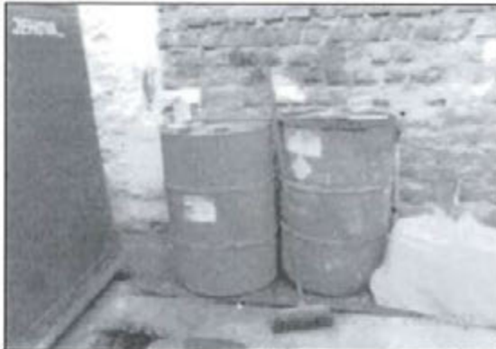
Fotografía N° 1 del Informe de Supervisión: Vista del almacenamiento de lubricantes y químicos en Muelle La Cruz. Obsérvese que el área no cuenta con doble sistema de contención y no se encuentra adecuadamente impermeabilizada.
