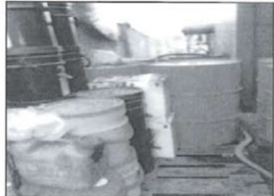
Fotografía N° 3 del Informe de Supervisión: Vista del almacenamiento de lubricantes y químicos en Muelle La Cruz. Obsérvese que el área no cuenta con sistema de doble contención de derrames.
