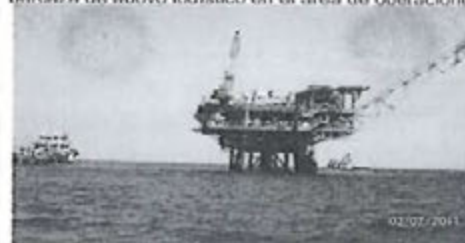
Foto 23: En el mes de julio no se encontró la barcaza de apoyo logístico en el área de operaciones.
