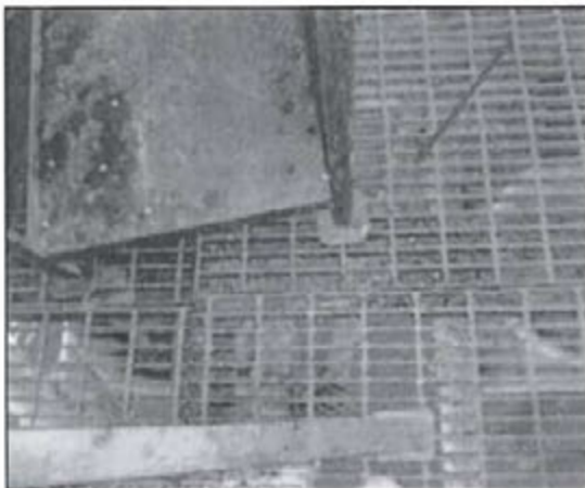
Fotografía N° 16 del Informe de Supervisión: Plataforma A-8, vista de la parrilla manchada con hidrocarburos ubicados a la altura del Pozo A-13E.
