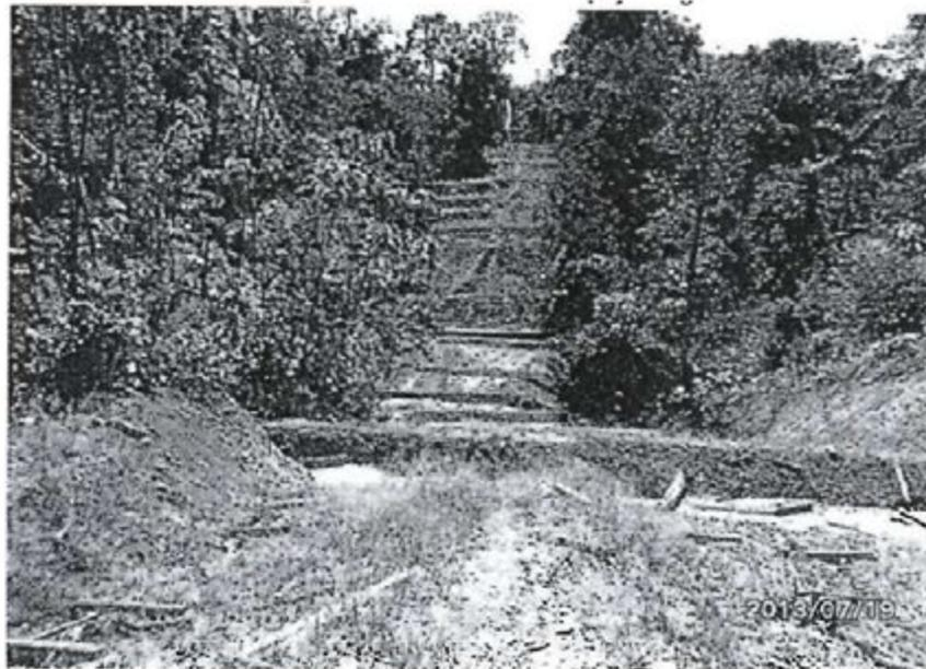
Punto del Flow Line Mipaya-Pagoreni B, con trabajos de control de erosión, reforestación y madera "picacheada". Coordenadas UTM: 699 725 E y 8 719 525 N 699 450 E 8 719 631. 699 450 E 8 719 631.
