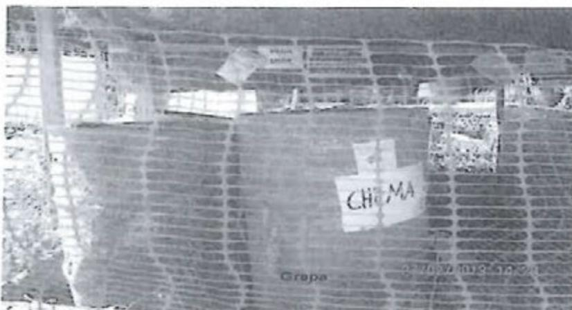
*En el Pit de combustibles del Campamento Temporal Pagoreni A, dos (02) cilindros de productos químicos se encontraban sobre una bandeja cubierta con geomembrana, se observó la falta de un sistema de doble contención que proteja y/o aisle a los productos químicos de los agentes ambientales.*
