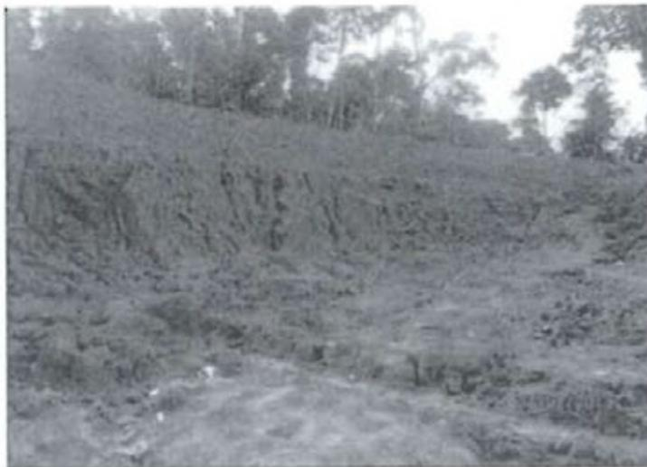
132. En la fotografía N° 10 si bien se observa estructuras de desviación (sacos blancos con tierra) para el control de la erosión, se evidencia surcos en el talud por la erosión hídrica, material disgregado y desprendimiento del mismo lo que genera inestabilidad del talud:
