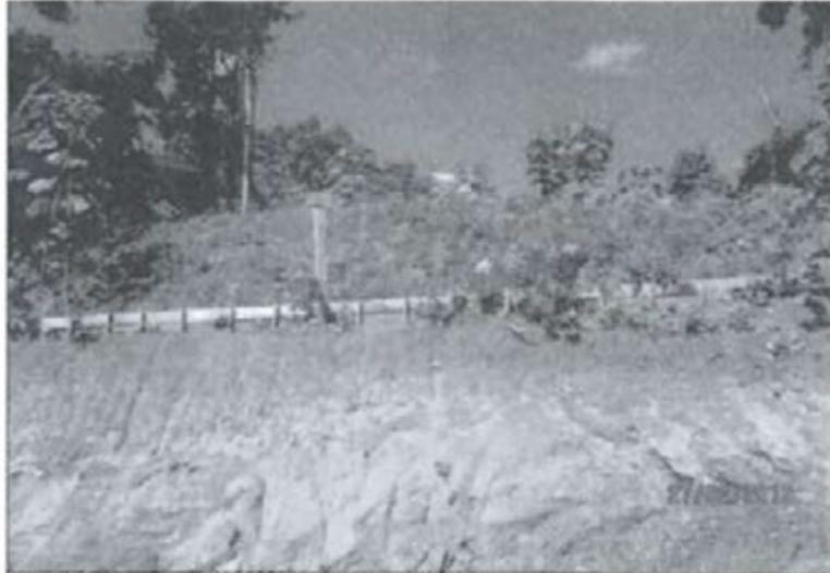
134. En la fotografía N° 12 se observa el deslizamiento del suelo en el talud, es decir que el talud ha perdido la estructura y estabilidad en su conformación, lo cual evidencia también una falta de control de la erosión:
