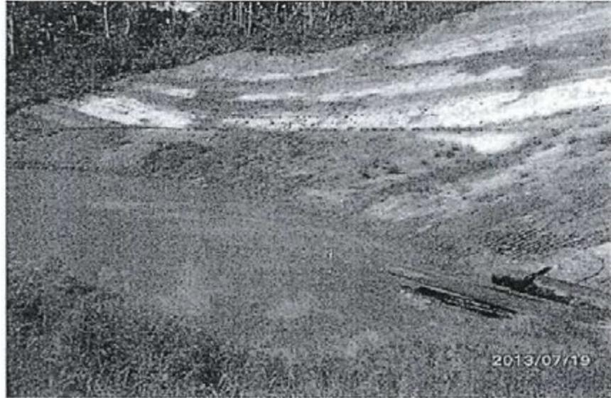
Fosa de Quema, los taludes tanto superior como inferior presentan trabajos de control de erosión con uso de biomantas y reforestación.
