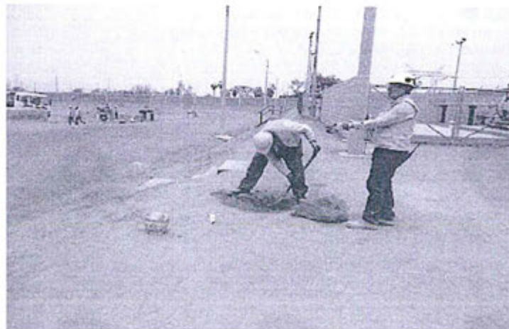
Vista fotográfica del Anexo 6
