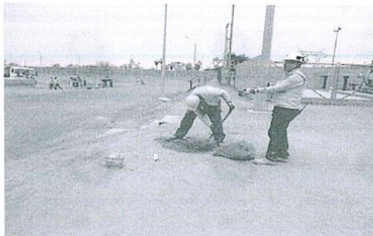
Vista fotográfica del Anexo 6
