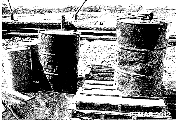
Fotografía N° 3: Los recipientes de los productos químicos utilizados en la cementación del pozo 11226 – Central, no tienen pegados las hojas de seguridad MSDS. Se observa falta de un sistema de doble contención
