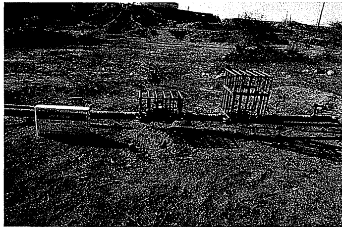
Vista panorámica de la válvula de bloqueo del tubo n° 184.
