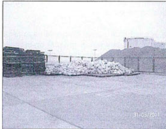
Fotografía N° 12: La Zona de Almacenamiento Temporal de Residuos Peligrosos se encuentra en un terreno abierto, asimismo no cuenta con un Sistema Contra Incendio.
