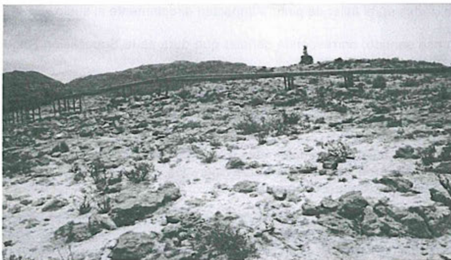
"Fotografía N° 42: Tubería de conducción de relave desde la planta a la relavera N° 6, nótese el derrame antigua de relave".
