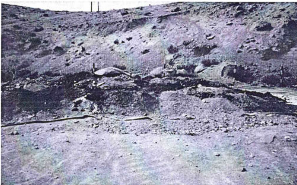
"Fotografía N° 171: Cancha de volatilización de suelos impregnados con hidrocarburos, obsérvese la inadecuada disposición de los suelos contaminados y la deficiente impermeabilización del suelo con geomembrana".
