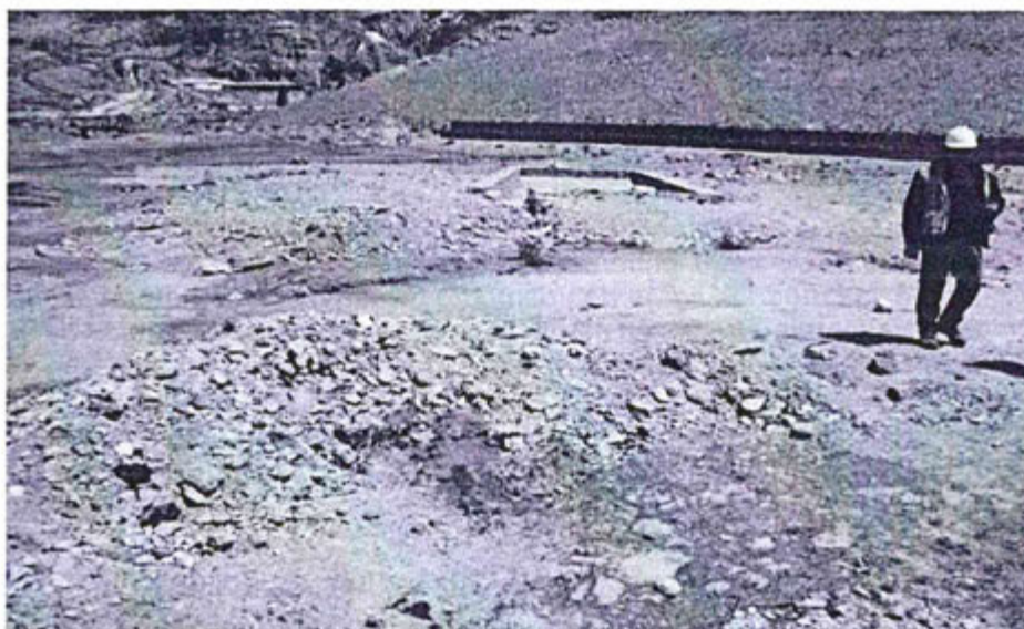
"Fotografía N° 75: Vista panorámica del sistema de tratamiento de aguas del subdrenaje del depósito de desmontes Mariana, el cual se encuentra inconcluso".
