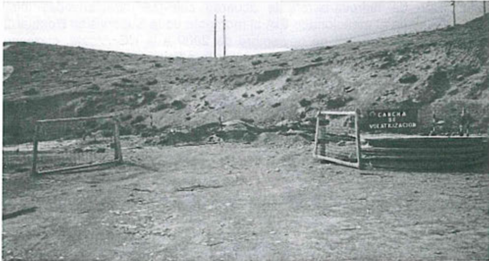
"Fotografía N° 172: Cancha de volatilización de suelos impregnados con hidrocarburos".
