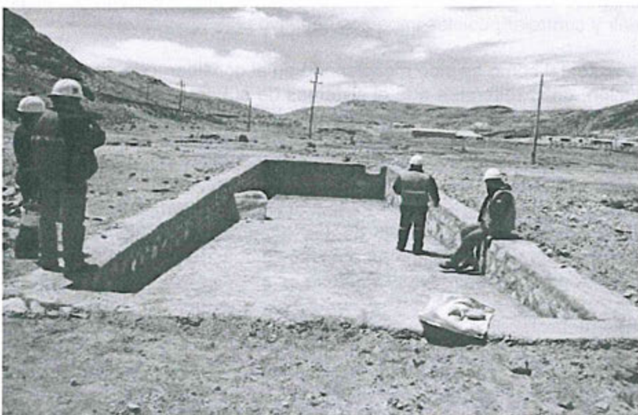
"Fotografía N° 65: Poza de sedimentación y tratamiento de los subdrenajes de la desmontera Mariana".
