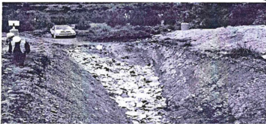
Foto N° 58: Condiciones de operatividad y mantenimiento del relleno sanitario de la U.E.A. Sipán
