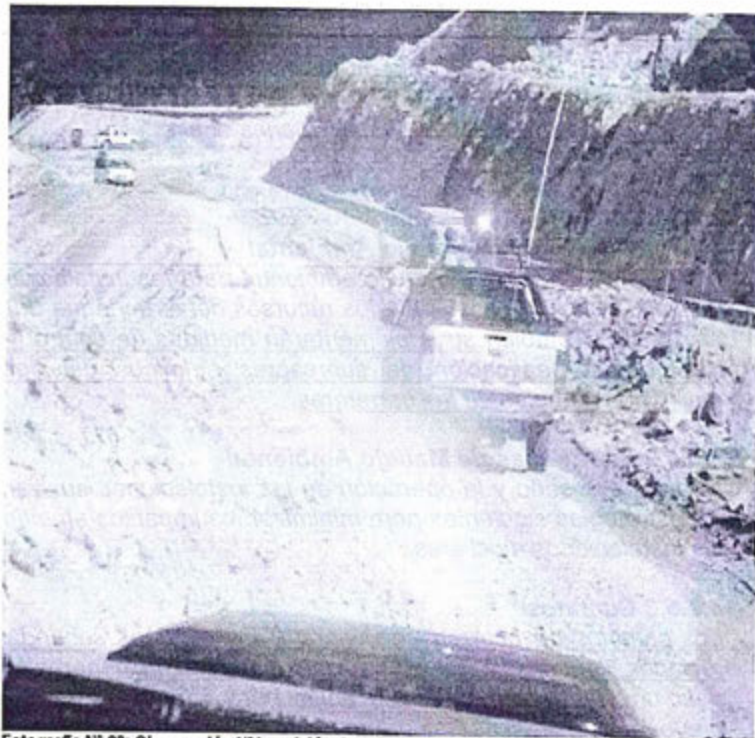
Fotografía N° 23: Observación N°1, emisión de polvos en las vías de acceso, falta de regado.
