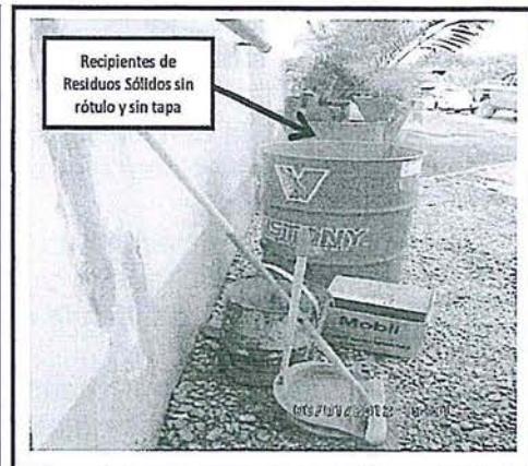
Fotografía N° 15.- En el Área de Almacenamiento Temporal de Residuos Sólidos Peligrosos de la Estación de Servicios, se observa que el Cilindro asignado a Residuos Sólidos Peligrosos no tiene rótulo y ni Tapa
