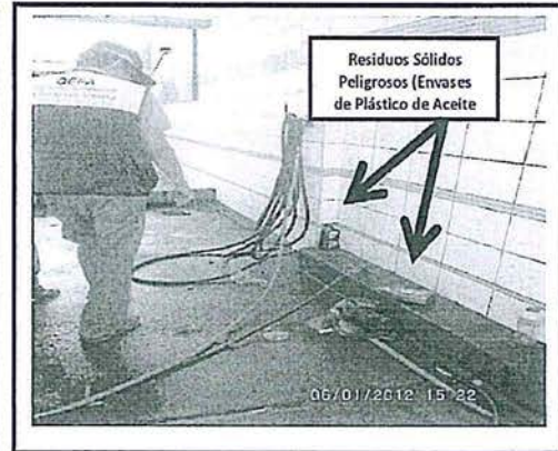
Fotografía N° 09.- En la Estación de Servicios se observa Residuos Sólidos Peligrosos (Envase de Plásticos de aceite, filtros usados de petróleo y aceite) dispersos en las Área de Lavado
