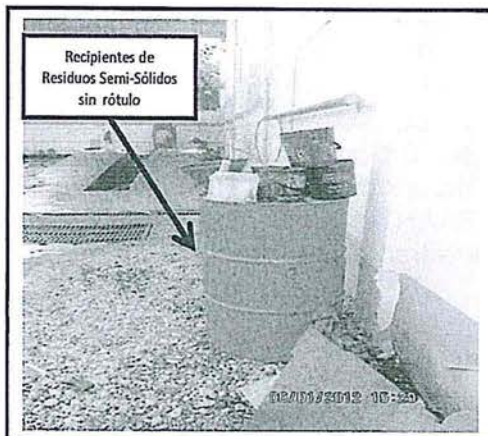
Fotografía N° 17.- En el Área de Almacenamiento Temporal de Residuos Sólidos Peligrosos de la Estación de Servicios, se observa que el Cilindro asignado a Residuos Semi-Sólidos Peligrosos no tiene rótulo
