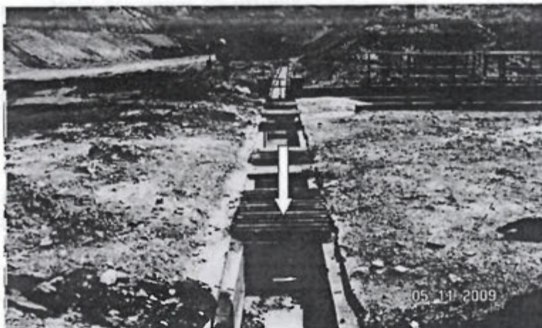
"Foto N° II.14.25 (2009) Se observa que del Sedimentador de agua de mina, se está evacuando el agua sin tratar al canal de escorrentía superficial"
