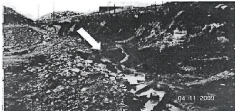
Foto N° II.14.16 Obs. N° 16 (2009) El depósito de Mineral de Planta no cuenta con una canal de derivación.
