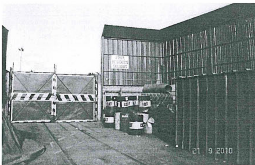
Foto N° 2.25 Obsérvese los cilindros de lubricantes usados dispuestos directamente sobre el piso
