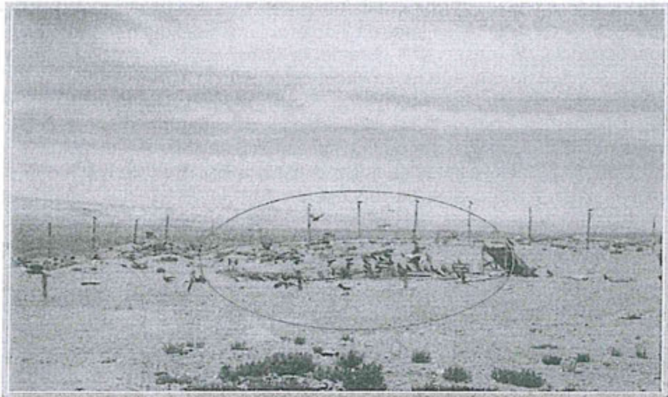
"Fotografía N° 76: Relleno sanitario de la U.O. Ares, obsérvese la fuerte cantidad de aves (vectores) directamente sobre la celda de confinamiento, debido a un deficiente manejo de esta (...)"
