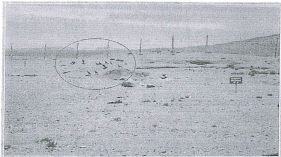
"Fotografía N° 77: Relleno sanitario de la U.O. Ares, obsérvese las águilas y aguiluchos (vectores) en las inmediaciones del relleno sanitario, acceden a la celda de confinamiento debido a un deficiente manejo de esta (...)"
