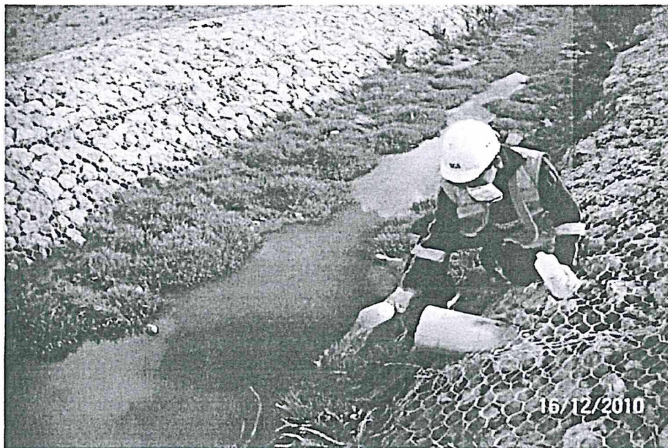
Fotografía N° 5: Toma de muestra del efluente del PTAR-09 con riesgo de caer el personal hacia el canal de aguas servidas.
