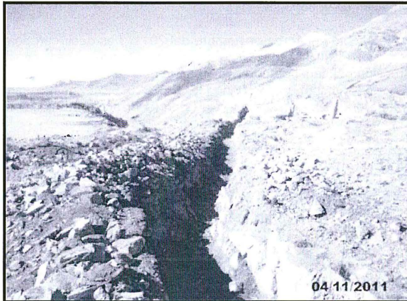
Fotografía N° 3 Canal de coronación de la Desmontera San Narciso tramo donde se profundizó el canal
