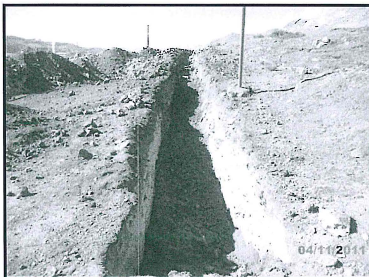
Fotografía N° 1 Canal de coronación de la Desmontera San Narciso, tramo inicial
