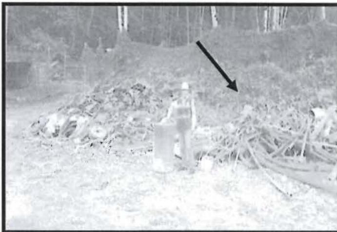
**"Fotografía N° 61 del Informe de Supervisión: Observación N° 05 supervisión regular 2012: Almacenamiento de residuos sólidos (cilindro, jebes, tuberías de PVC, etc.) sobre el suelo y sin identificación, sobre suelo."**
