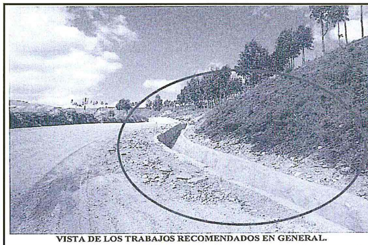
VISTA DE LOS TRABAJOS RECOMENDADOS EN GENERAL.
