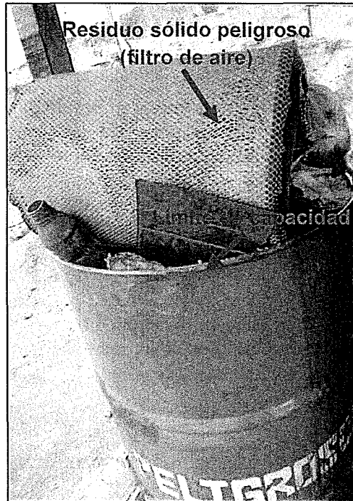
Fotografía N° 14 del Informe de Supervisión.- Inadecuada segregación de residuos peligrosos que rebasa el recipiente.
