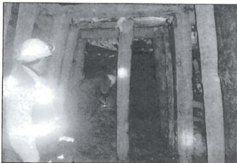
Fotografía N° 7. Labores de sostenimiento, para el mantenimiento del nivel 4330.
