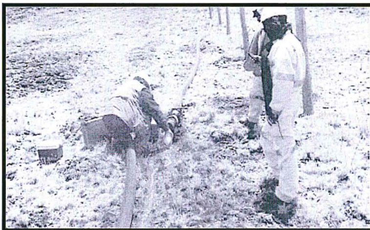
Fotografía N° 85: Vista fotográfica de la descarga DPTR no autorizada de la planta de tratamiento de agua residual.
