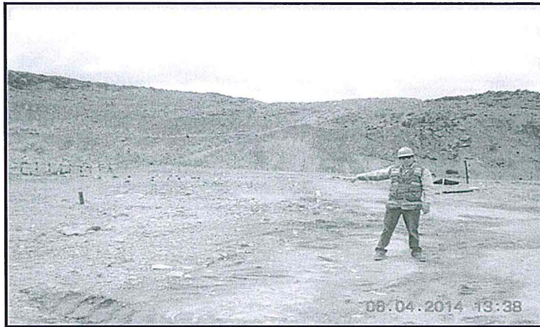
Vista de la parte ya nivelada dentro del relleno sanitario Selene.
