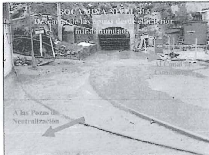
Se observa que las aguas de la laguna Ñañantioc 1 que ingresaron por la bocamina del nivel -10 son descargadas por la bocamina del nivel 415 (zona inundada con aguas ácidas). Una parte de la descarga se dirigió hacia las pozas de neutralización y otra hacia el canal de coronación de la laguna Huarangayoc.
