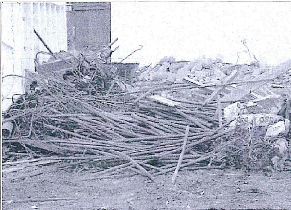
**Fotografía N° 42.** Detalle de composición de residuos de construcción (fierros, maderas, plásticos, restos de concreto) no segregados y dispuestos sobre el suelo.
