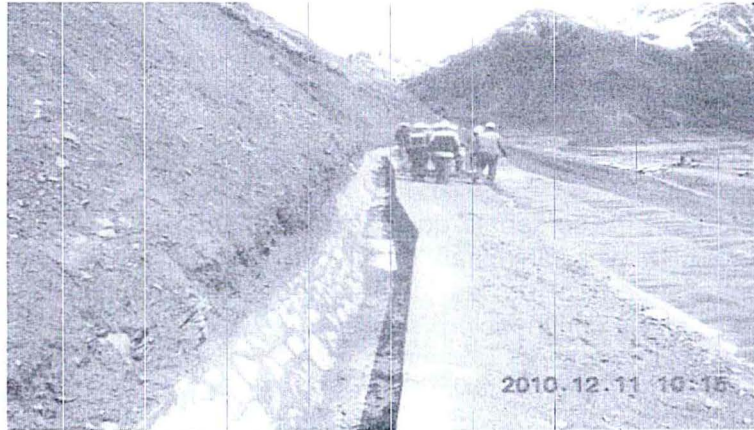
Fotografía N° 39: El canal de coronación cuenta con dos pendientes, en el EIA se menciona una sola pendiente.
