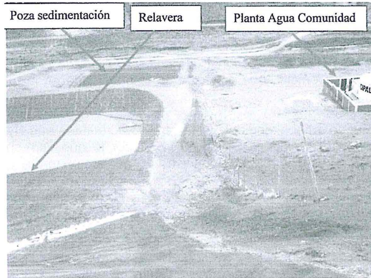
Fotografía 12: Poza de sedimentación instalada en la parte baja del depósito de relaves.
