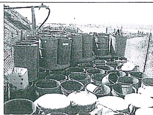
Vista 3. Los residuos peligrosos se almacenan en cilindros sin tapa y sin clasificar
